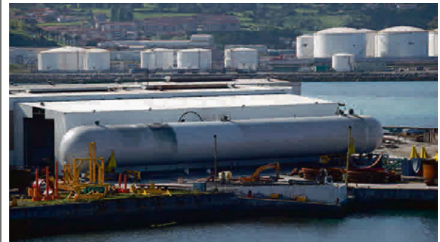
Un tanque de almacenamiento de gas construido por Duro Felguera en el Tallero, a pie de puerto, para la holandesa Vopak. | JUAN PLAZA
